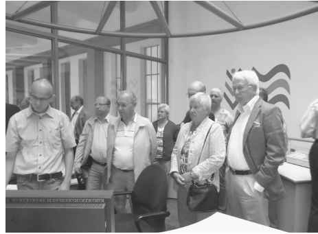
In der Schaltzentrale des Wasserwerkes
